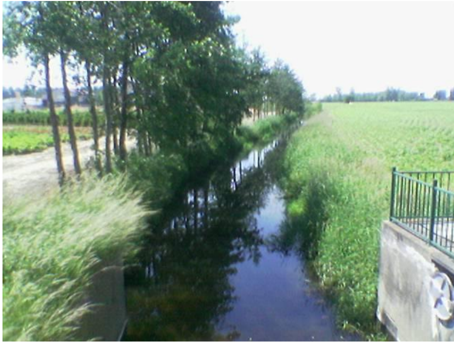
Afleidingskanaal te Nevele
